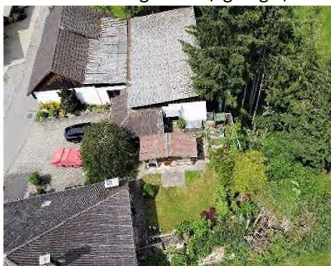
ausseansicht lagerhalle / garage / wintergarten
